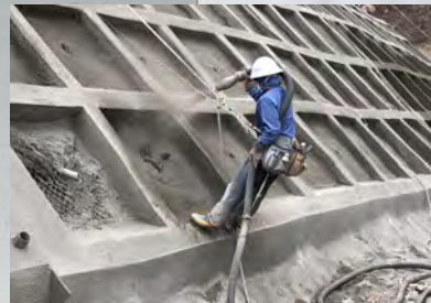
のりめん 法面吹付けの リバウンドロス削減にも有効
