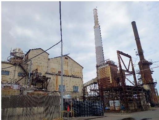
既設発電所建屋外観
